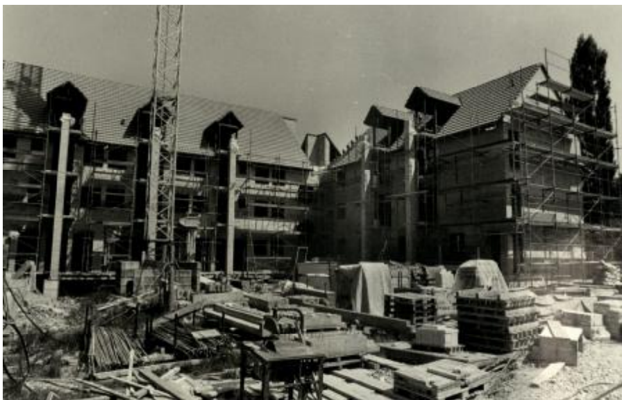
Das RomeroHaus im Bau, ein Jahr vor der Eröffnung im Jahr 1986
